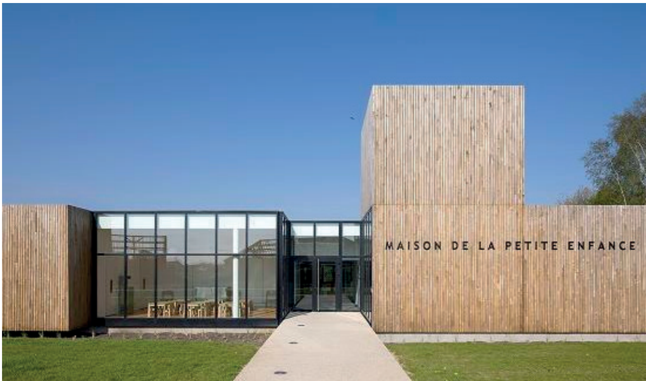
exemples de constructions aux volumétries marquées, en bardage bois
